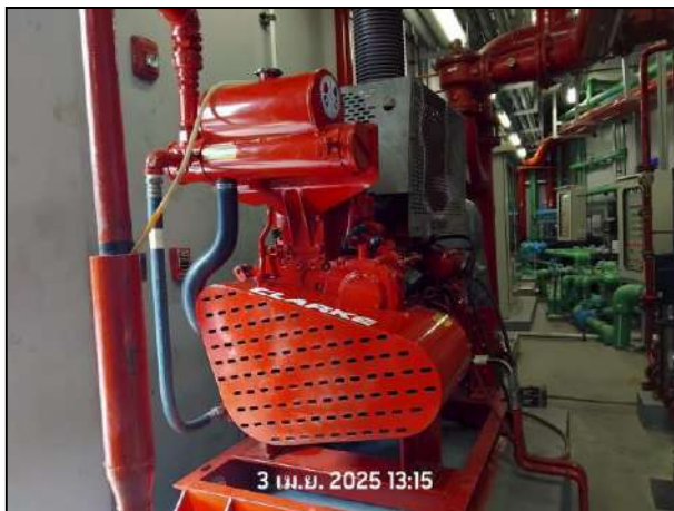
รูปที่ 2.41 ระบบ Fire Pump
