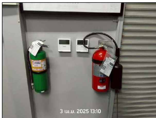
รูปที่ 2.24 ถังดับเพลิงชนิดมือถือ
